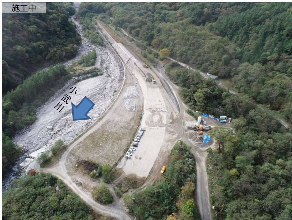
下流側より上流撮影
