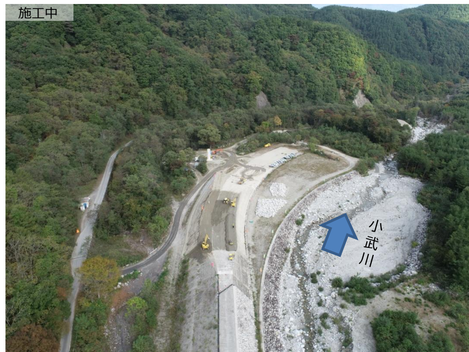
上流側より下流撮影
