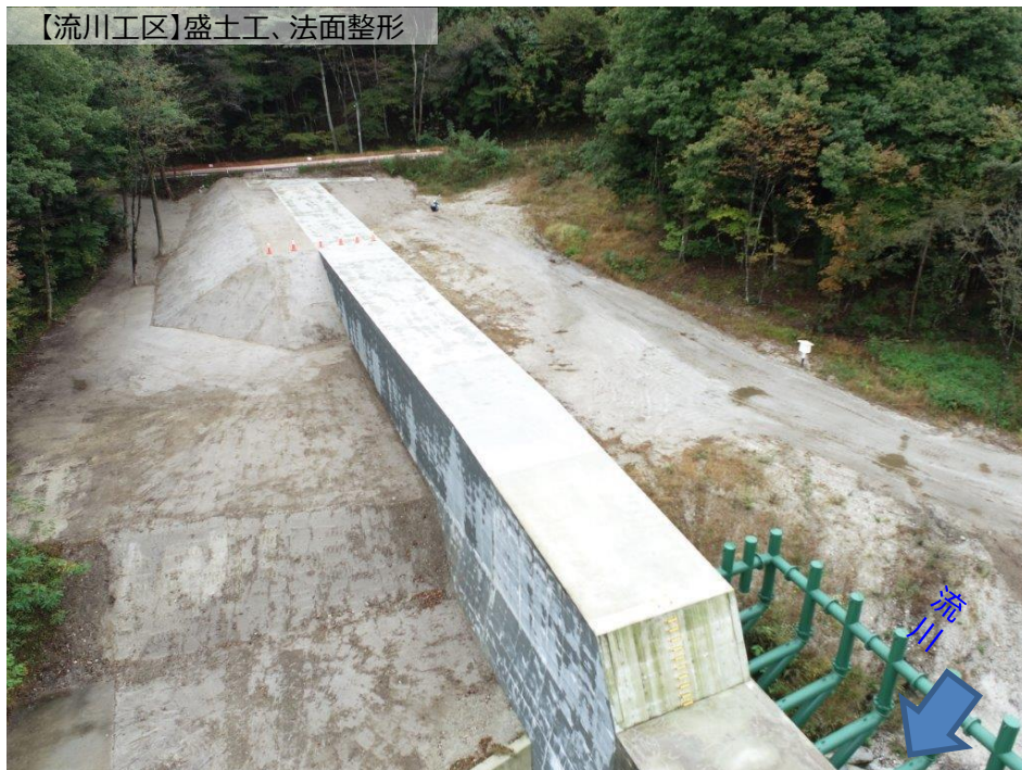
下流側より右岸撮影
