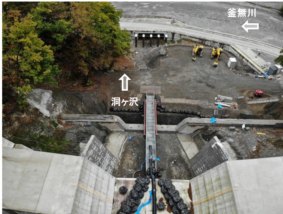
上流上空より施工箇所を望む
