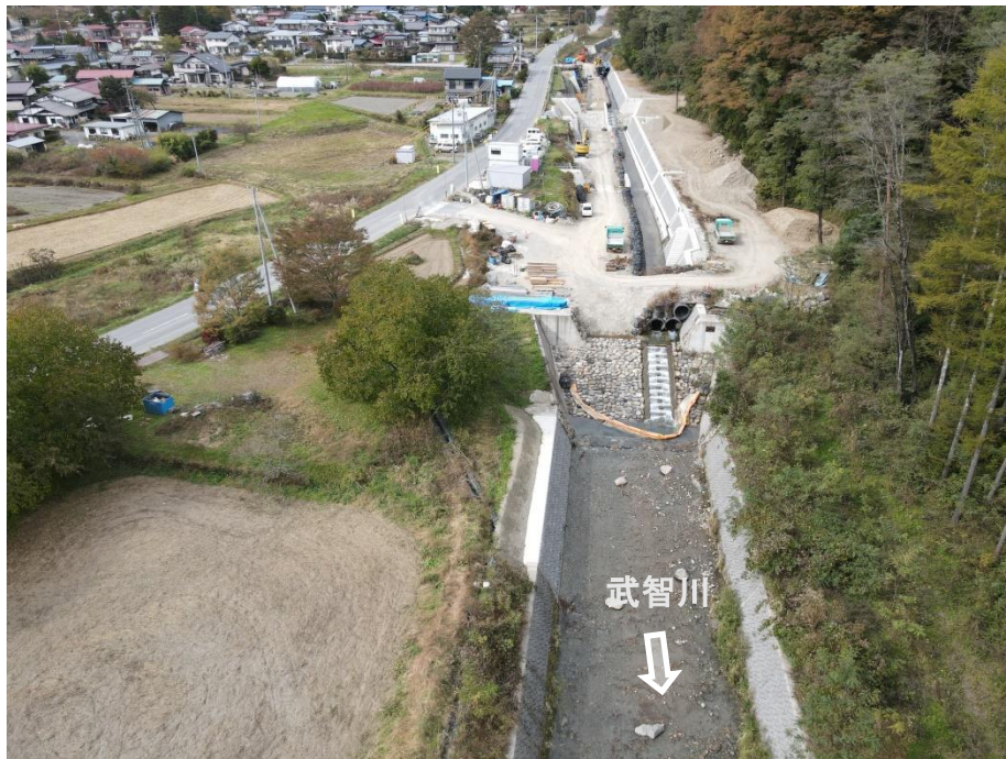
下流上空より 施工箇所（全景）を望む
