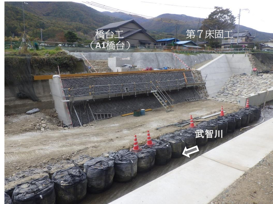
左岸より施工箇所を望む （流路護岸工 ブロック積擁壁工）
