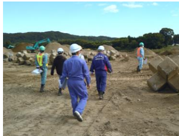
工事安全パトロールの様子▶
