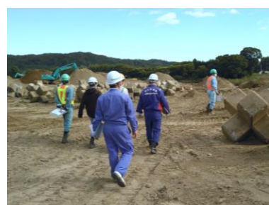
工事安全パトロールの様子▶
