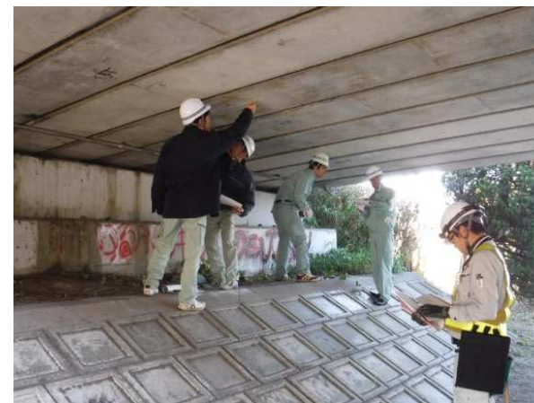
【橋梁点検研修会】
