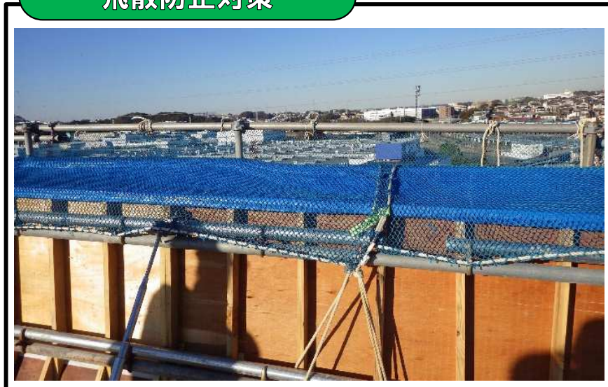
養生マットに飛散防止ネットを設置
