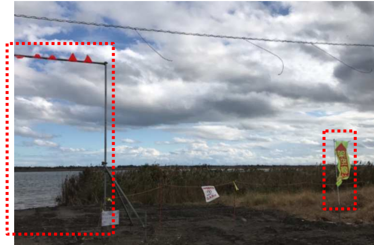
高さ制限、のぼり旗の設置
