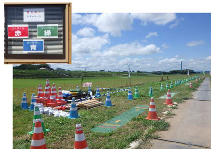
カラーコーンの色分けで、 立入禁止（赤）・安全通路（緑）・資材置場（青）を明示
