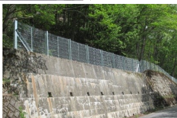
<落石防止柵の取替>
