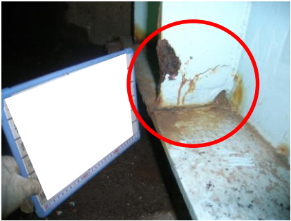
主桁の腐食
