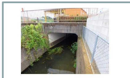
■ 溝橋(ボックスカルバート)
