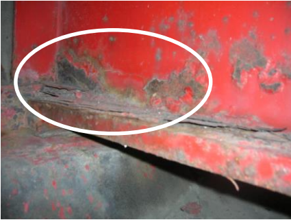
主桁の腐食
