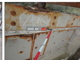
〔補強鋼板の浮き・腐食〕
