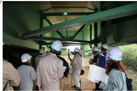
高所点検カメラの試行状況
