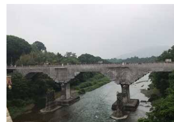
【上部工の足場設置】
