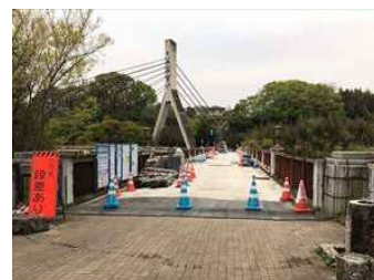
【橋面上の現況】
