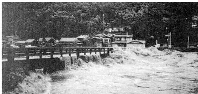
桁下高不足による支障事例
