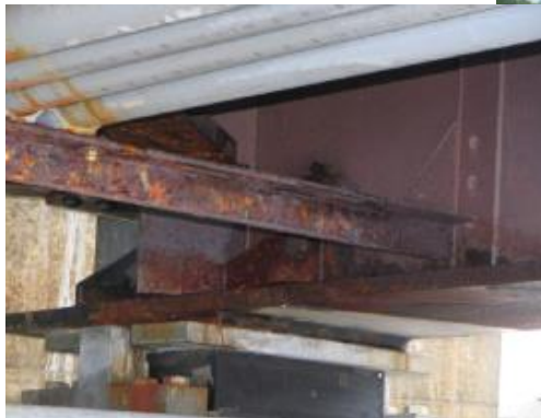
橋面排水の影響による腐食
