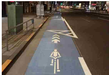
(国道246号:青山地区)
