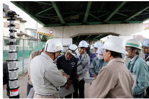
橋梁ロボットカメラの試行状況
