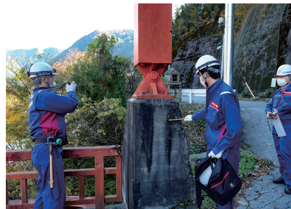
現地調査の様子
