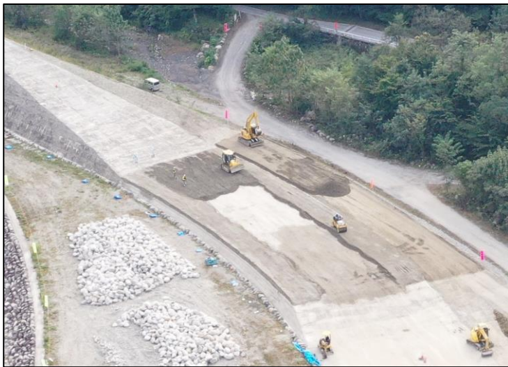
〔施工箇所空撮〕
