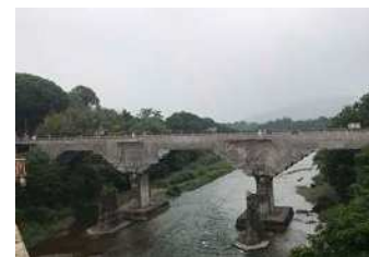
【上部工の足場設置】
