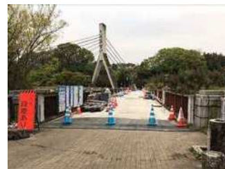
【橋面上の現況】
