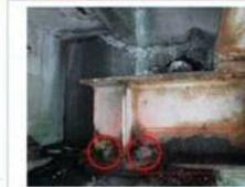
所見：伸縮装置からの漏水により、橋梁に減厚を伴う著しい腐食が見られる。ウェブ下部にて層状の腐食による板厚減少が見られ、耐荷力の低下が疑われ、放置した場合には座屈するおそれがある。控え材の姿勢を保つアンカーボルトの状態も現状を評価するに重要となることから、ボルト頭部のたたき点検等により状態を確認するとよい。群衆荷重および床版の荷重が直接作用する部材であるので、速やかに伸縮装置からの漏水対策を施して、腐食の原因を排除するとともに、湿潤環境を改善するとよい。
