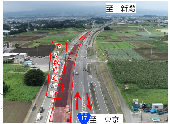
上武小神明交差点付近・施工状況（R4.9） ※現在・片側2車線通行、下り線側施工中
