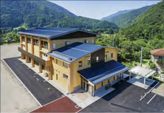
日光市立三依小中学校屋内運動場及び 三依公民館・三依地区センター 日光市
