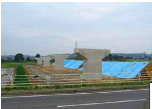
神崎高架橋(大栄JCT方向を望む)
