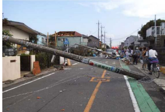
竜巻（2013年9月） ⇒電柱倒壊：約50本
