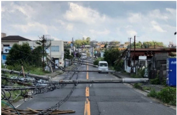
台風21号（2018年） ⇒電柱倒壊：約1,700本
