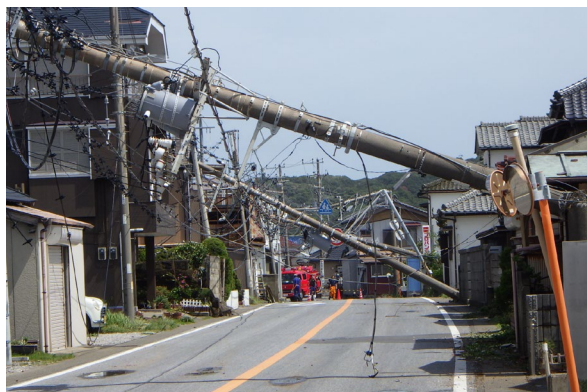
台風15号（2019年） ⇒電柱倒壊：約2,000本
