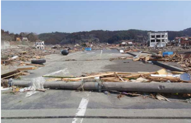
東日本大震災（2011年3月） ⇒電柱倒壊：約56,000本
