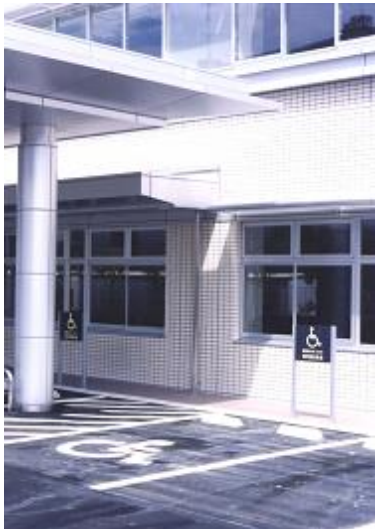
車いす利用者用駐車場の整備
