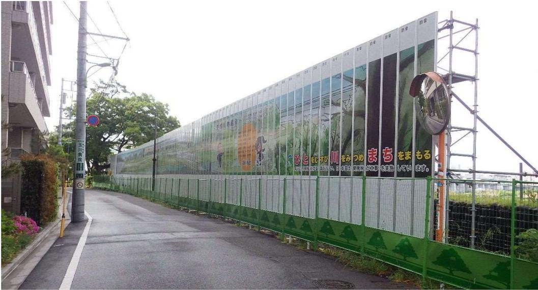
騒音対策として、現在下流側に設置している防音パネルを、マンションと施工箇所の間
