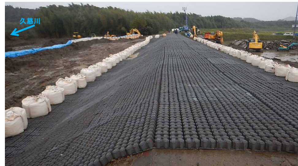
完成状況写真 2019.10.25 19時00分頃
