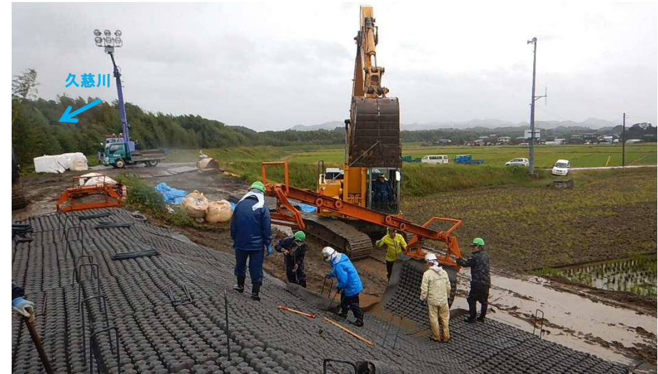
2019.10.25 15時00分頃 ブロックマット設置 施工中
