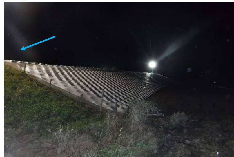
完成状況写真 2019.10.21 22時00分頃
