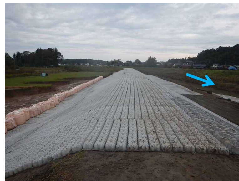
完成状況写真 2019.10.28 07時00分頃
