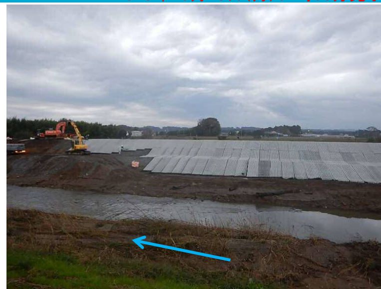
2019.10.27 17時00分頃 ブロックマット 施工中
