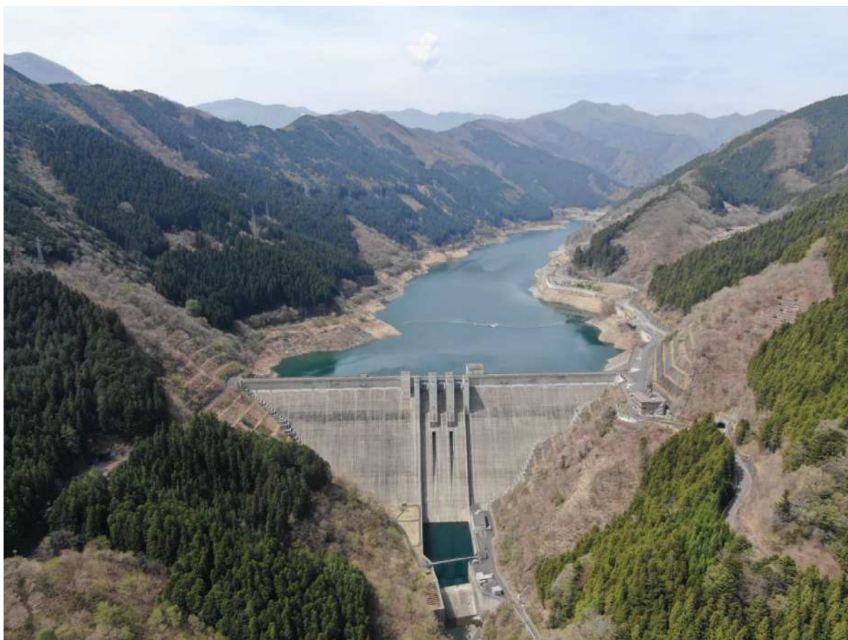
滝沢ダム上流域の状況（令和4年4月13日撮影）
