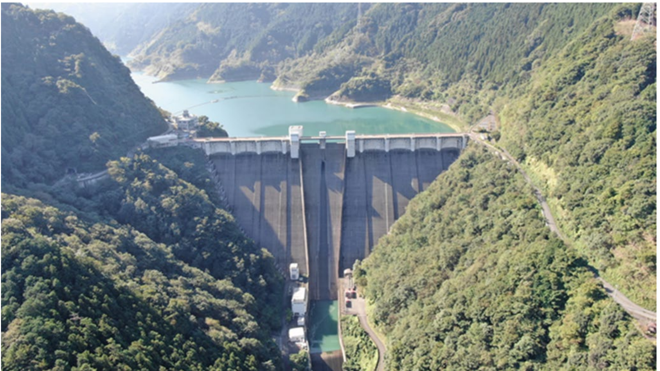
浦山ダム（令和4年9月30日撮影）
