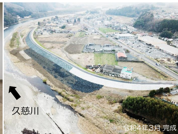
-工事完成状況-
