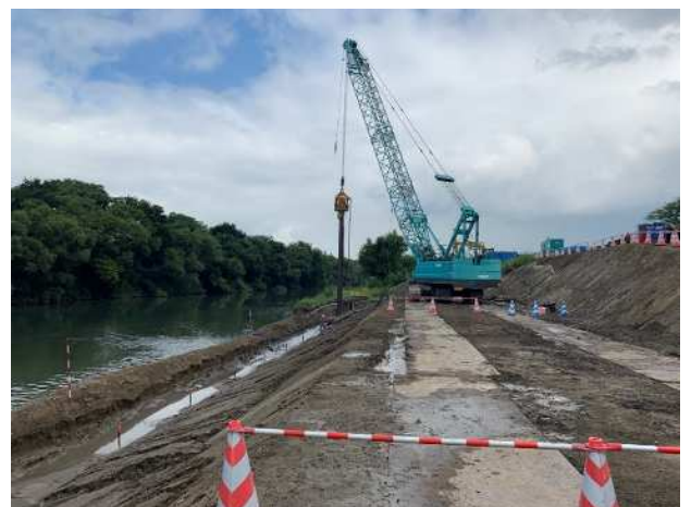
鋼矢板打設工
