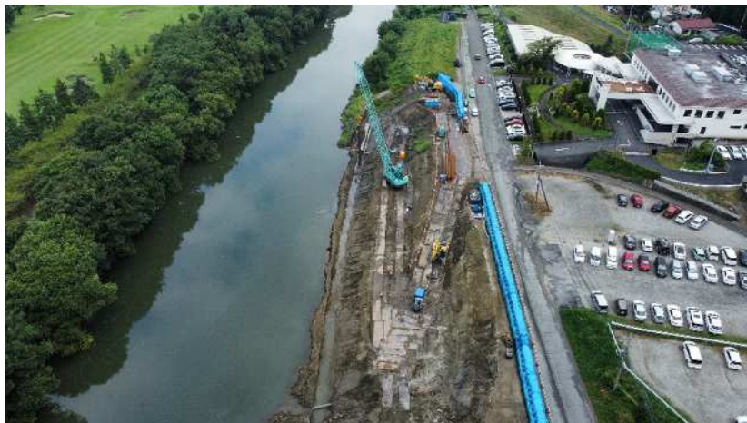
施工状況全景
