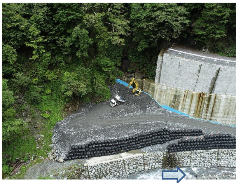
【右岸側より施工箇所を望む】
