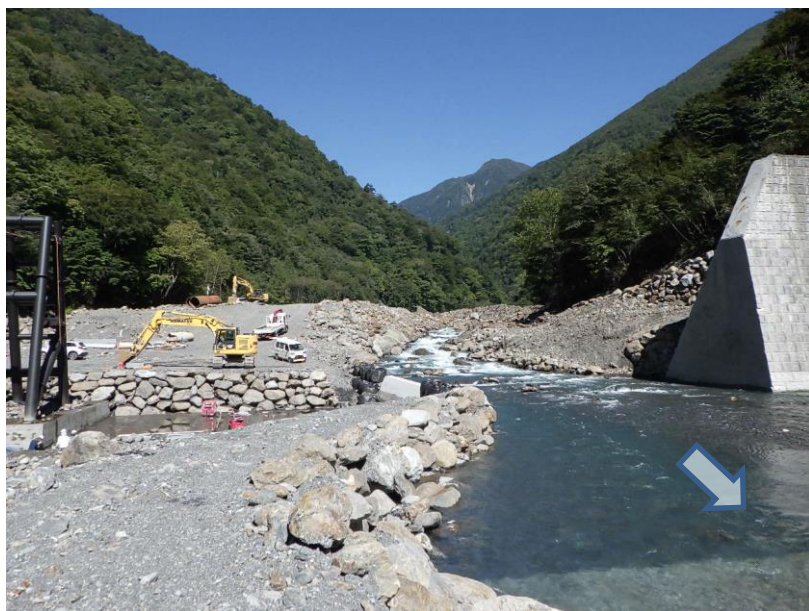
【下流側より施工箇所を望む】
