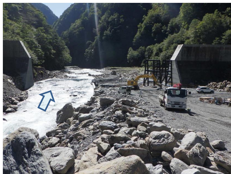
【上流側より施工箇所を望む】
