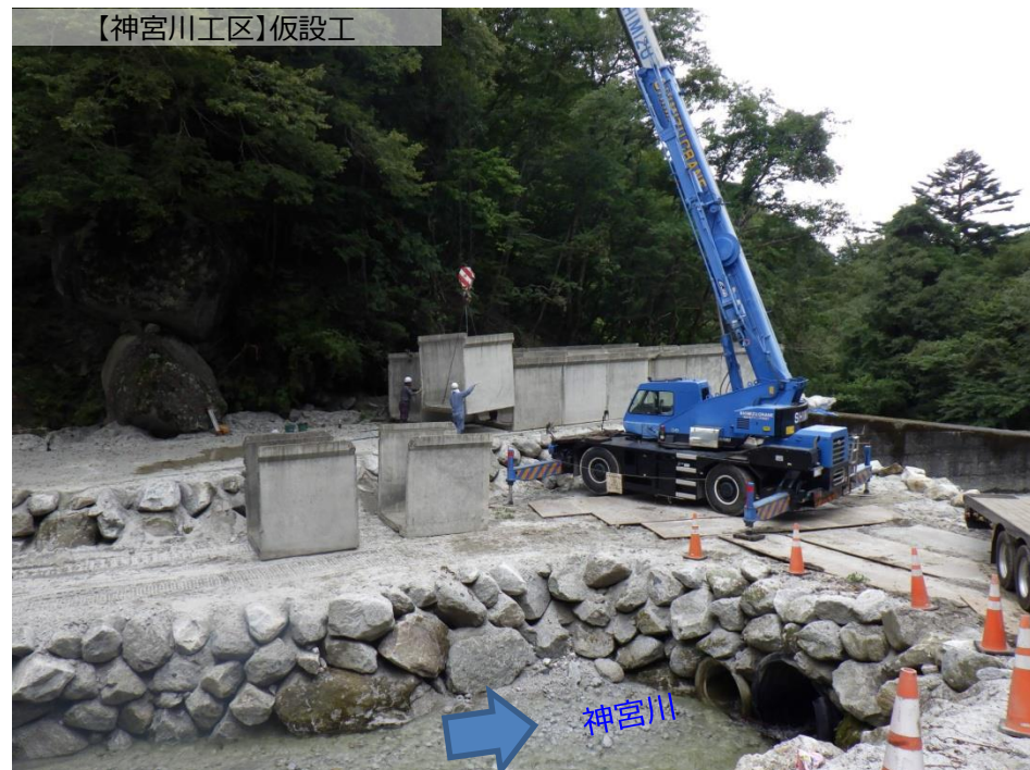
【神宮川工区】仮設工 河川内撮影
