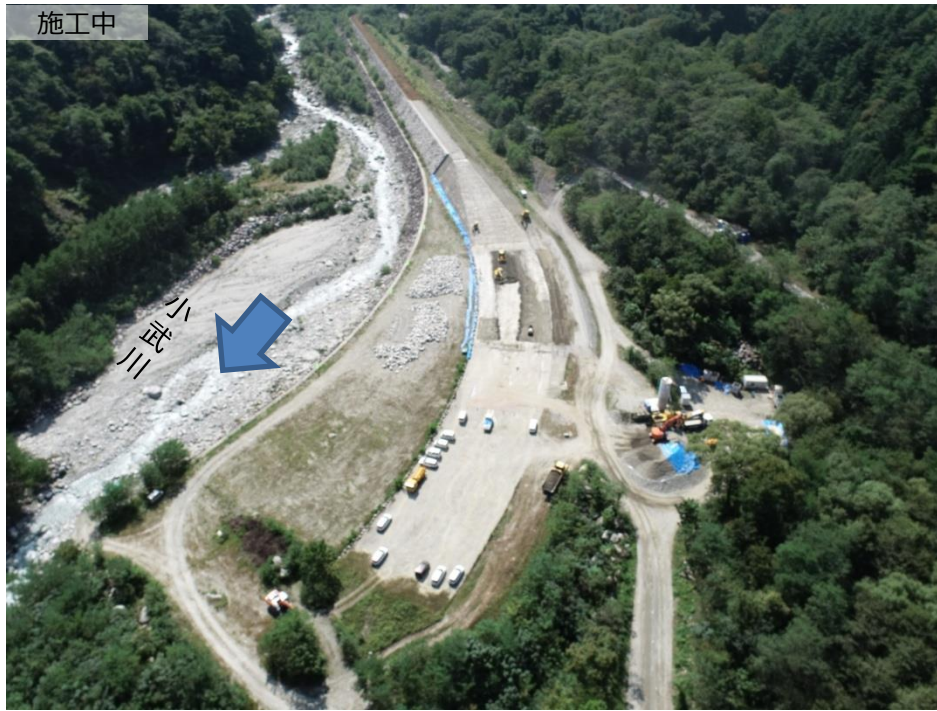
下流側より上流撮影
