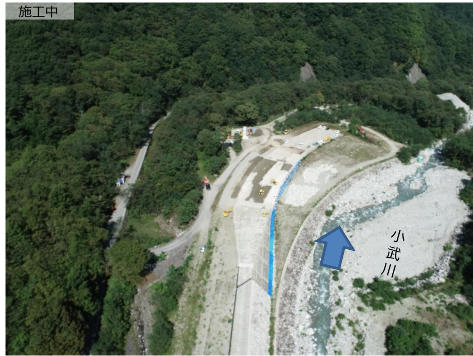
上流側より下流撮影
