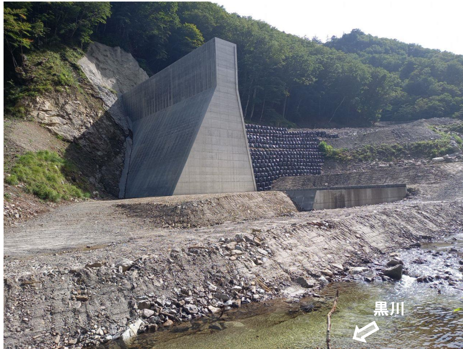
【完成】下流より本堰堤を望む（コンクリート堰堤工）
