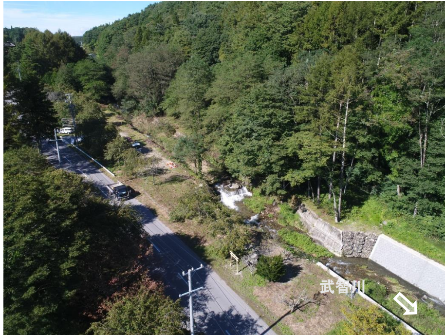
上空より施工箇所を望む
