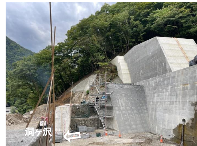
左岸より右岸を望む→
