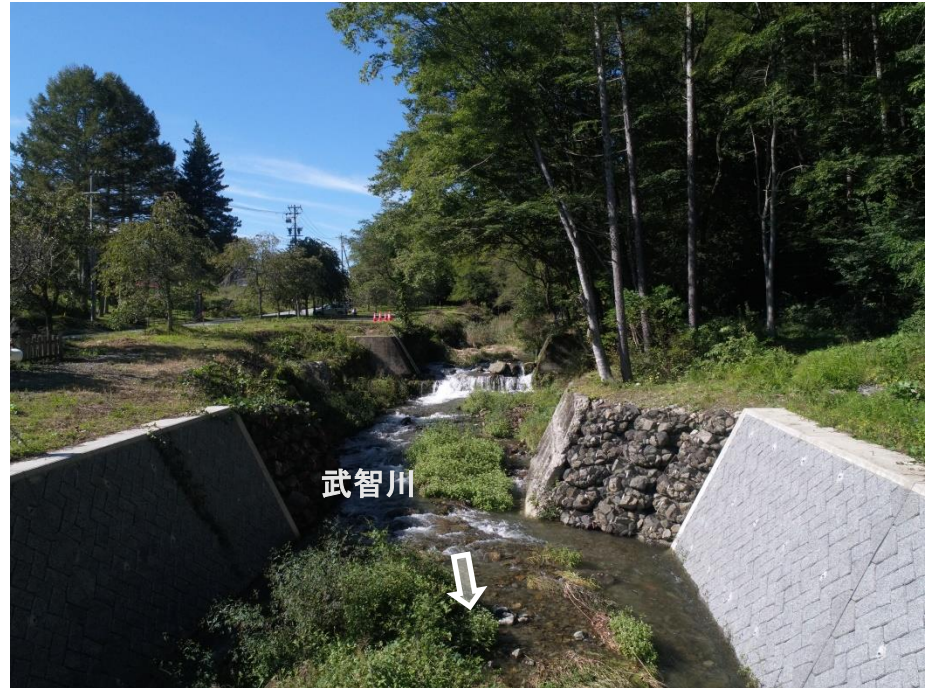
下流より施工箇所を望む
