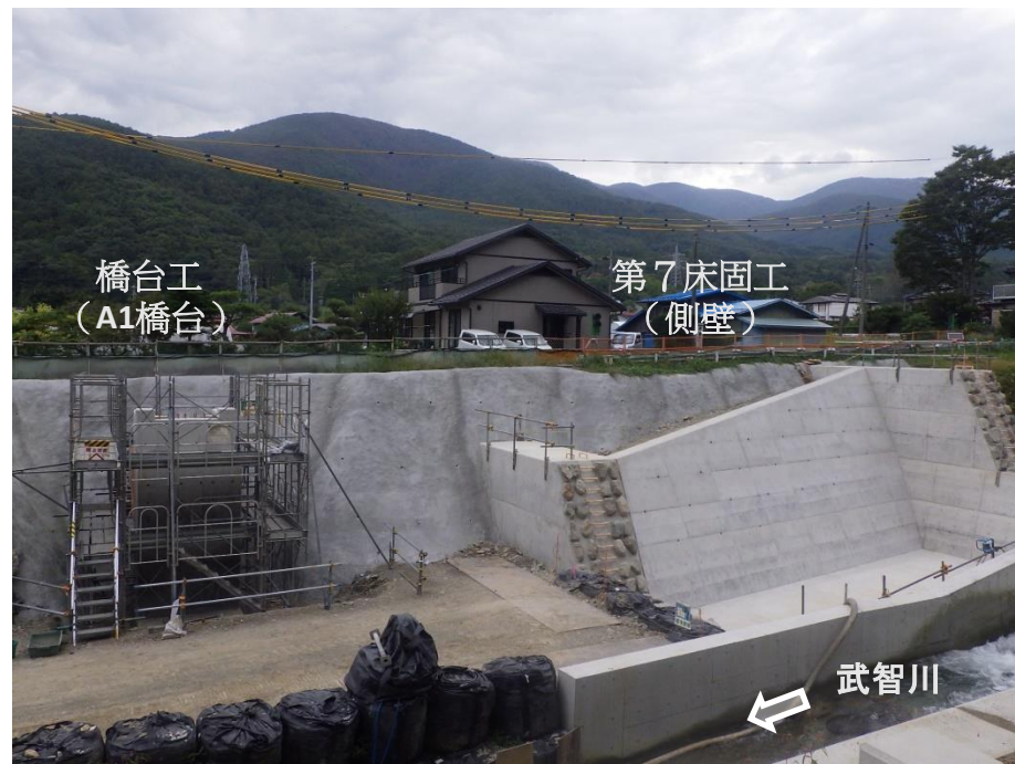
左岸より施工箇所を望む （第7床固工（側壁）、橋台工（A1橋台））
