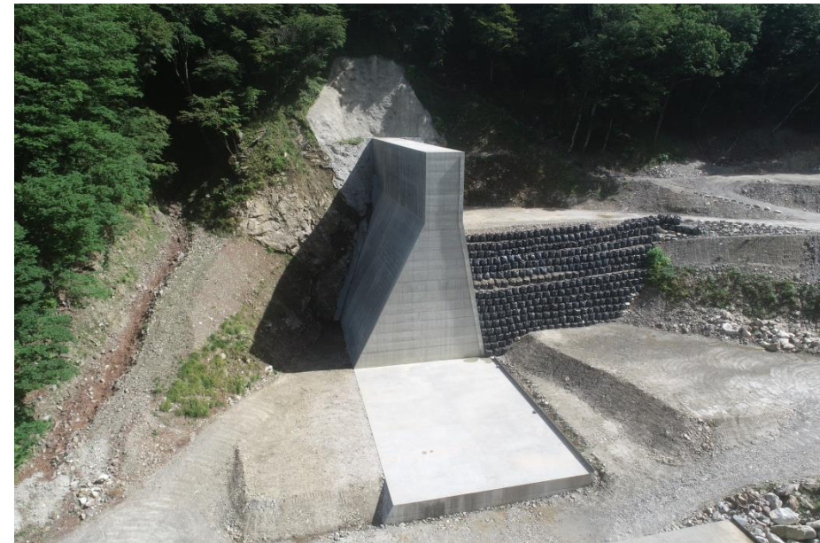
【完成】下流 左岸上部より本堰堤を望む （コンクリート堰堤工）
