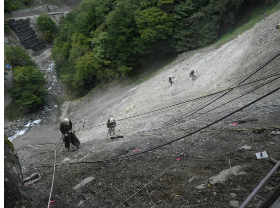
施工箇所上部より施工箇所を望む
