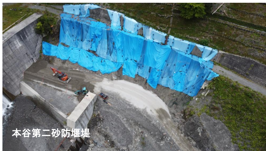
上空より施工箇所を望む（A地区）
