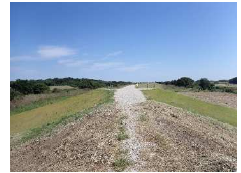
写真① 上流端から下流方向
