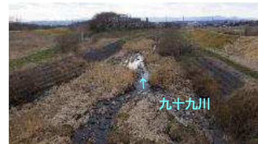
写真① 九十九川水門から下流方向
