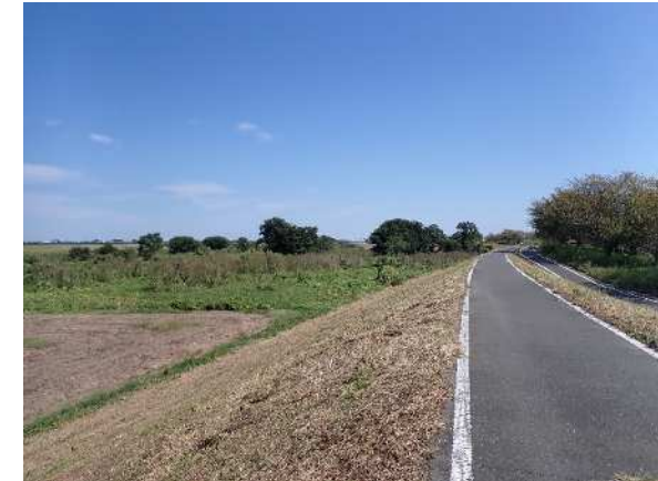
写真① 堤防から下流方向
