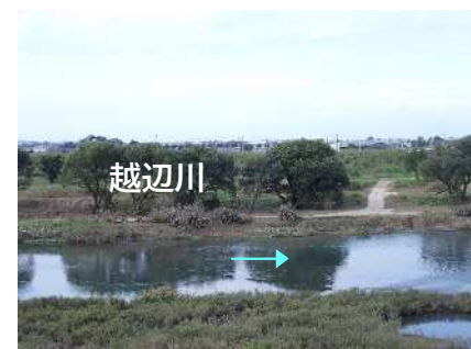
写真② 背割堤から工事方向
