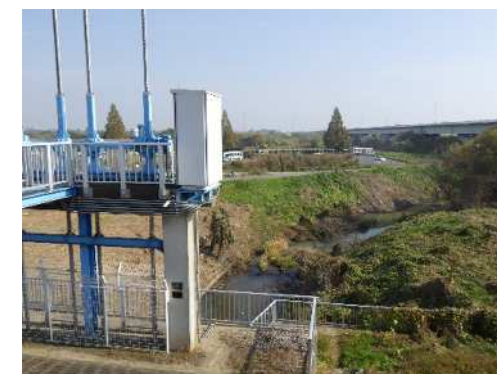
写真① 古谷樋管より入間川方向
