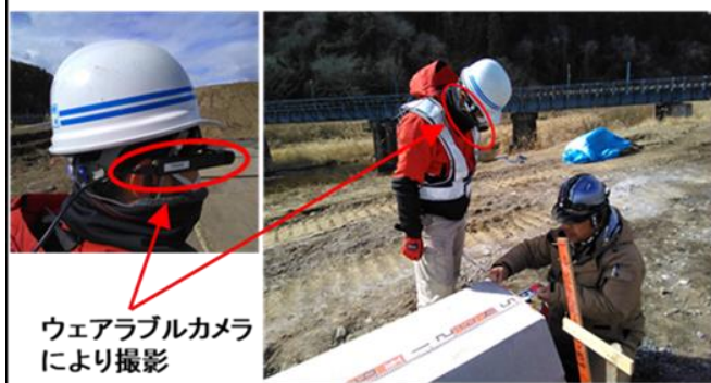
現場での受注者による撮影状況
