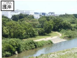
水際に緩やかな護岸を整備
