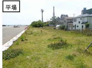
堤防の一部を拡幅し、平場を整備
