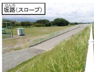
堤防から河川敷に緩やかな坂路を整備
