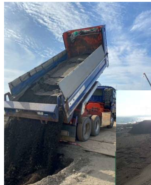
▲建設発生土の受入
