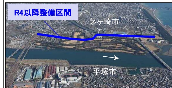
▲高潮堤防整備(茅ヶ崎市中島地区)
