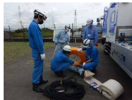
▲ポンプの組立
