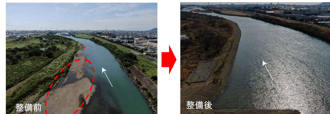
▲河道掘削工事の状況(国管理区間) (神奈川県平塚市田村地先)
