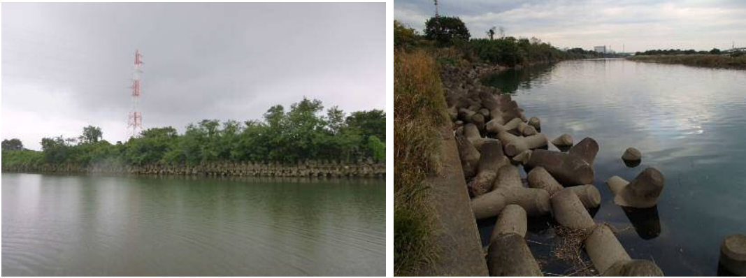
▲河岸際に侵食防止の根固めを投入
