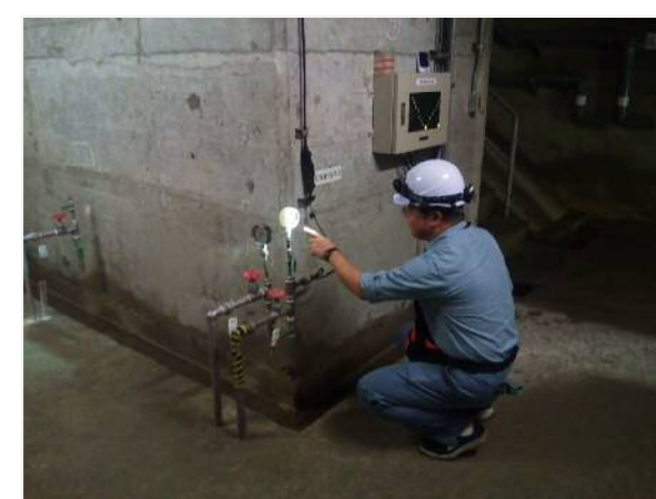
▲ 宮ヶ瀬ダムの施設の点検状況
