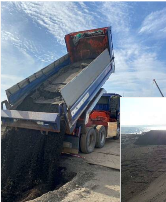
▲建設発生土の受入状況
