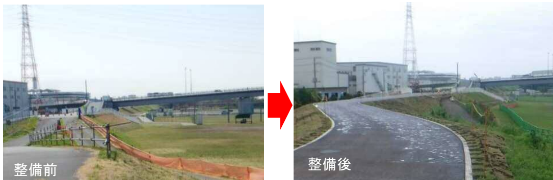
▲堤防整備の状況(国管理区間) (神奈川県高座郡寒川町田端地先)
