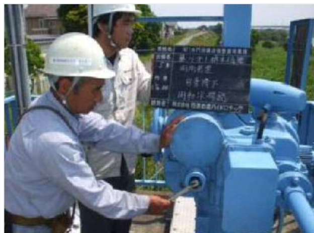
▲ 河川管理施設の点検状況
