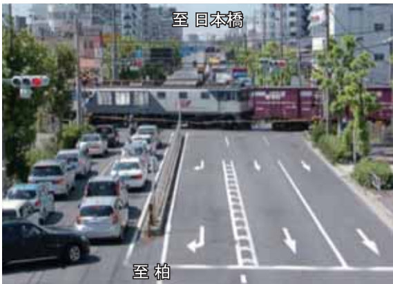
新宿踏切による交通阻害(新宿三丁目交差点)
