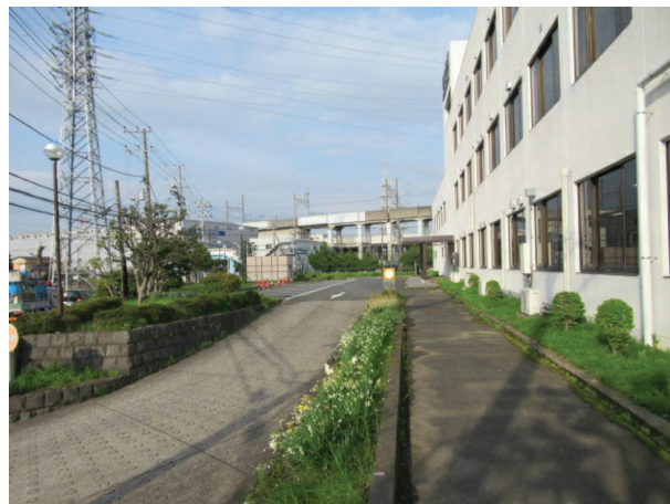
②建物外観
