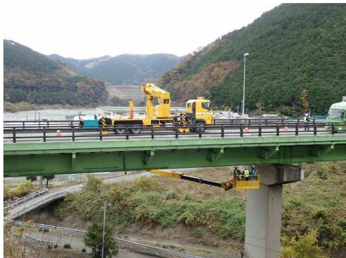
橋梁点検車による点検のイメージ写真
