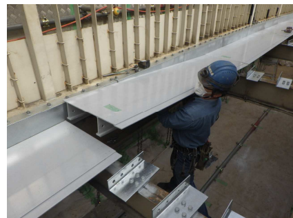
写真-4 高耐食性(FRP 製)の軽量床版
