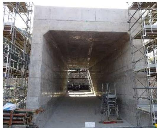
■ 8号函渠(本体完了・盛土工施工中)
