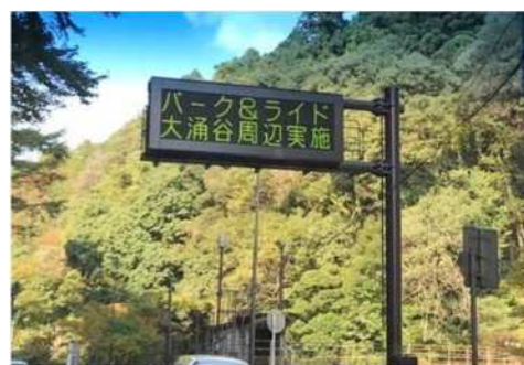
小田原土木センター管轄情報板 【函嶺洞門】
