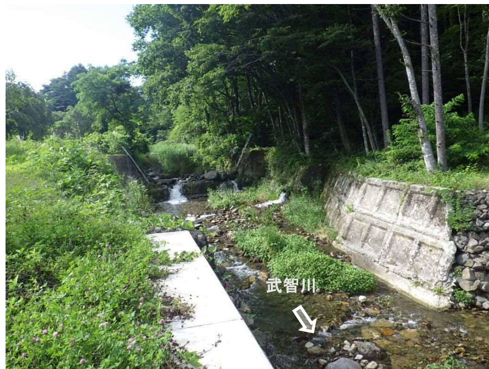
【着手前】下流より施工箇所を望む
