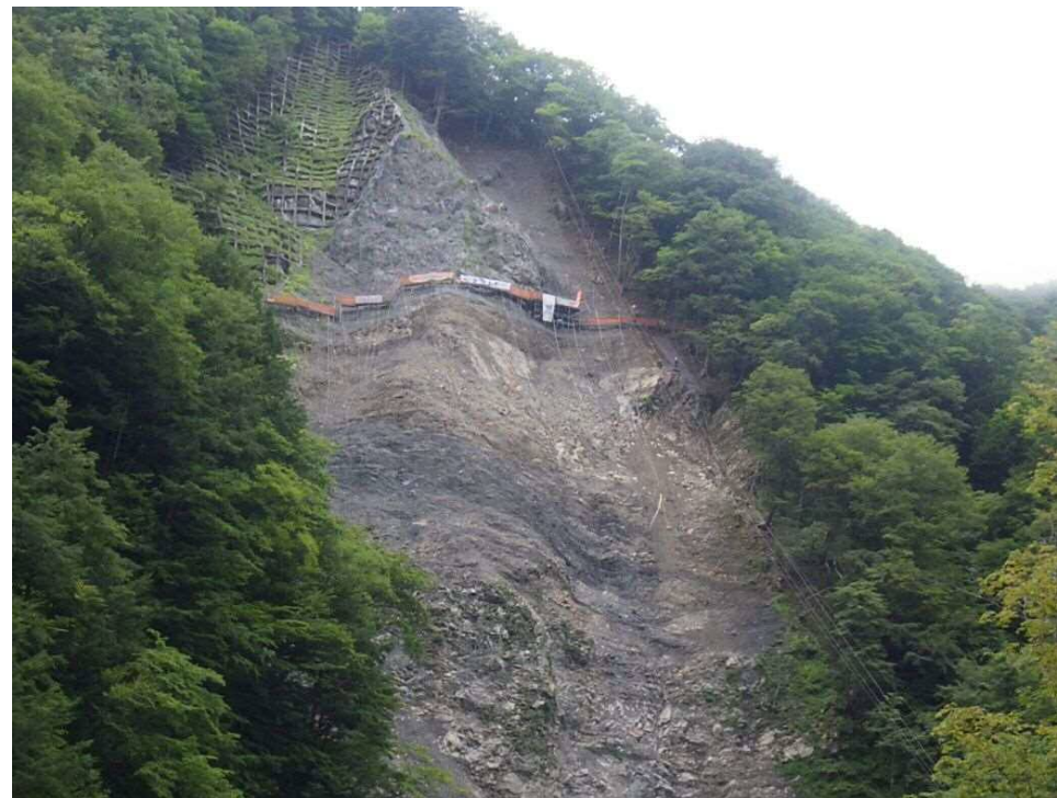
対岸より施工箇所を望む
