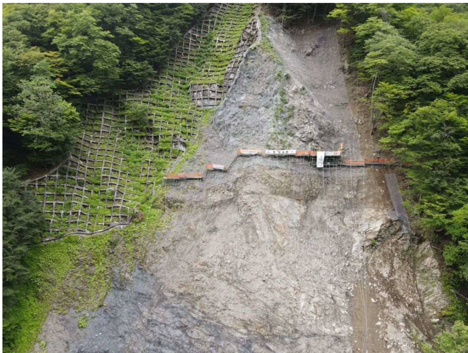
上空より施工箇所を望む
