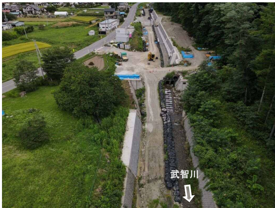
下流上空より 施工箇所（全景）を望む
