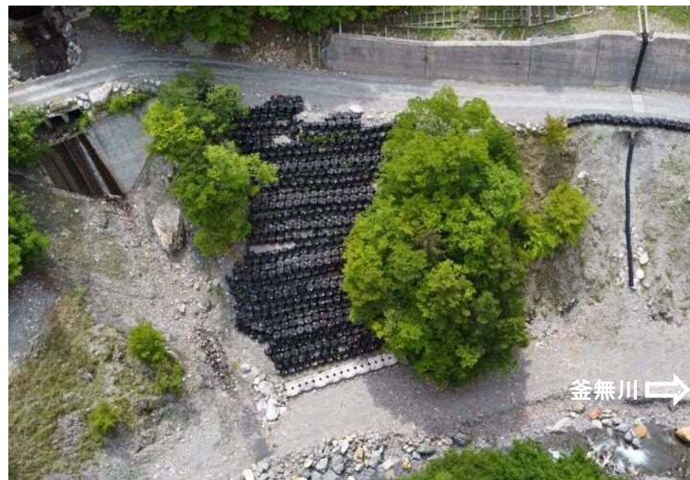
【着手前】上空より施工箇所を望む（I地区）
