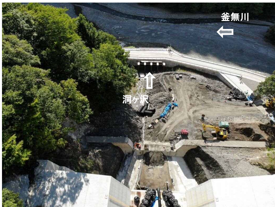
上流上空より施工箇所を望む
