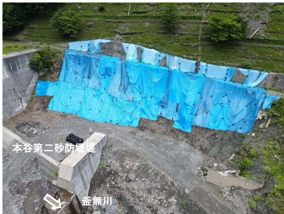
【着手前】上空より施工箇所を望む（A地区）
