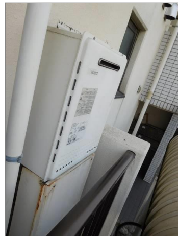
既設給湯設備 (給湯器)
