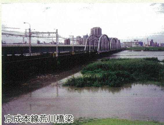
■ 洪水時、橋桁のすぐ下まで水位が上昇
