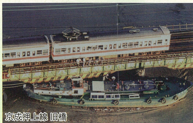
■ 増水して橋桁に衝突した運搬船
