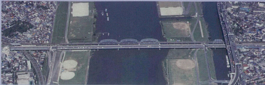
京成本線荒川桥梁全景
