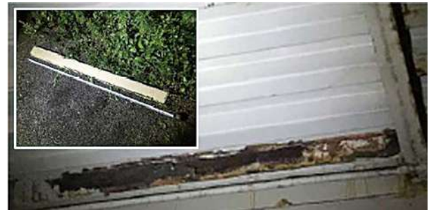
写真－4 あて板が落下した歩道橋
