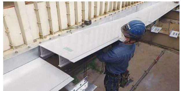
写真－5 高耐食性床版(FRP)の施工状況
