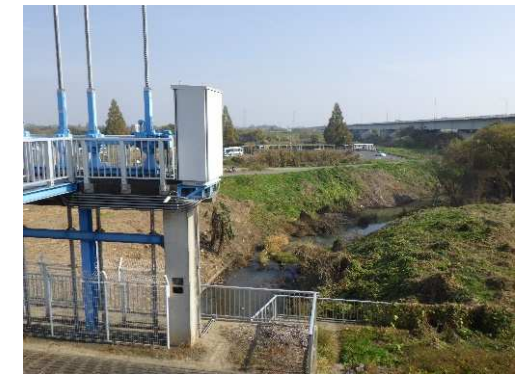
写真① 古谷樋管より入間川方向
