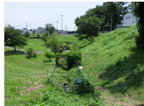
写真② 万世樋管より堤内地方向
