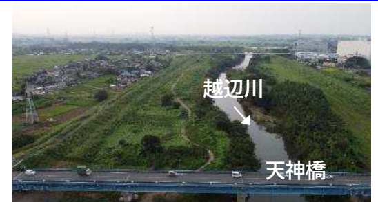
写真① 天神橋上空より上流方向全景
