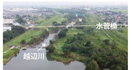
写真② 上流上空より下流方向全景
