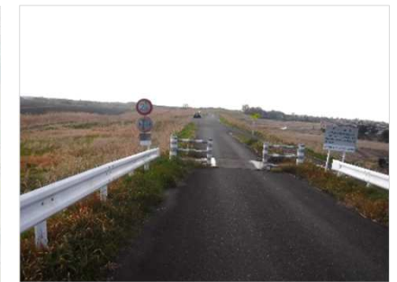
写真① 下流端より上流方向
