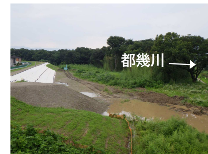
写真① 新東松山橋から上流付近
