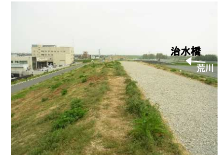
写真② 堤防から荒川方向
