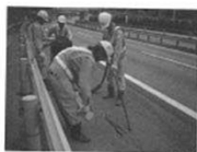
写真-4.2.10 シール材注入状況
