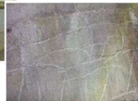
下部工のひび割れ
