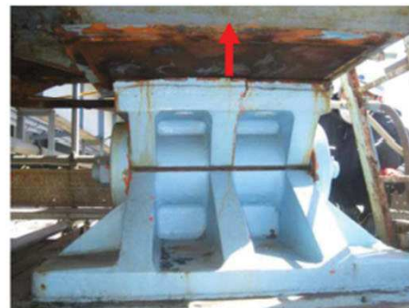
P2支承（固定）： 下弦材と上脊の間の溶接が外れ上部構造が移動
