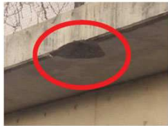
コンクリート片(40cm×25cm×9cm) 県道上に落下
