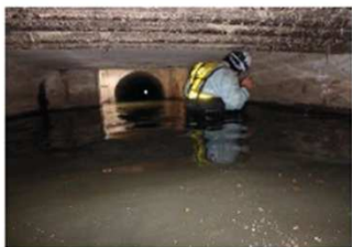
滞水した溝橋内部の目視点検
