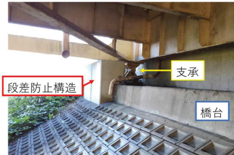
主桁下面の支承前面に設置した例
