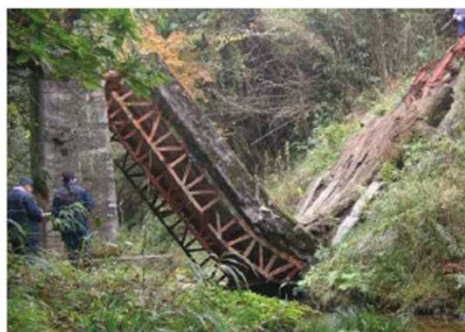
写真1 老朽化が原因で落橋した国内事例
