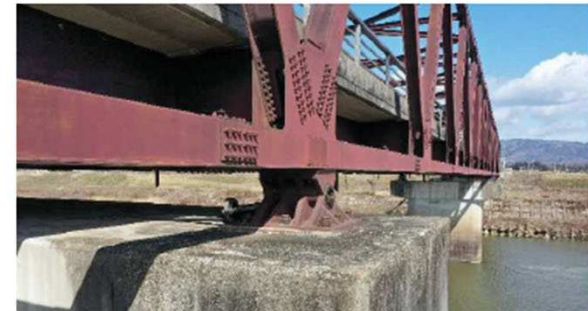
P2支承（固定）：ピンの脱落
