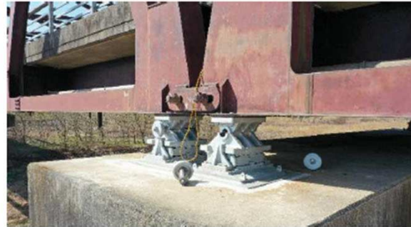
P3支承（可動）：ピンの脱落
